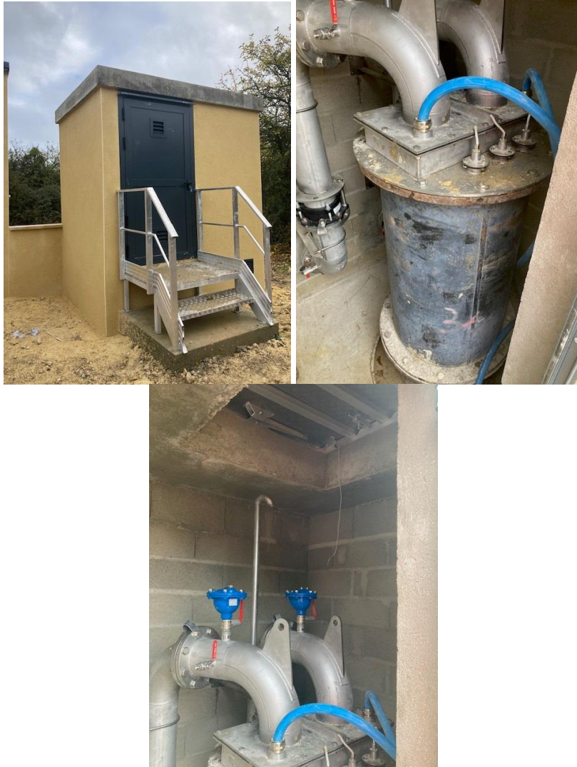
Local technique et tête du forage F2
